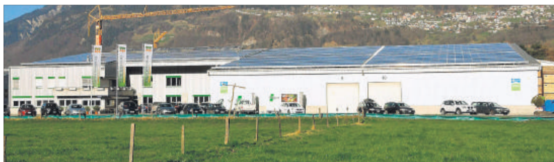
Einer der grössten Solaranlagen der Ostschweiz. (Bild: Heidi Beyeler)
